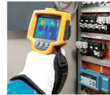
**CAMARA TERMOGRÁFICA:** Permite detectar recalentamiento de componentes eléctricos del ascensor. Previsión.
